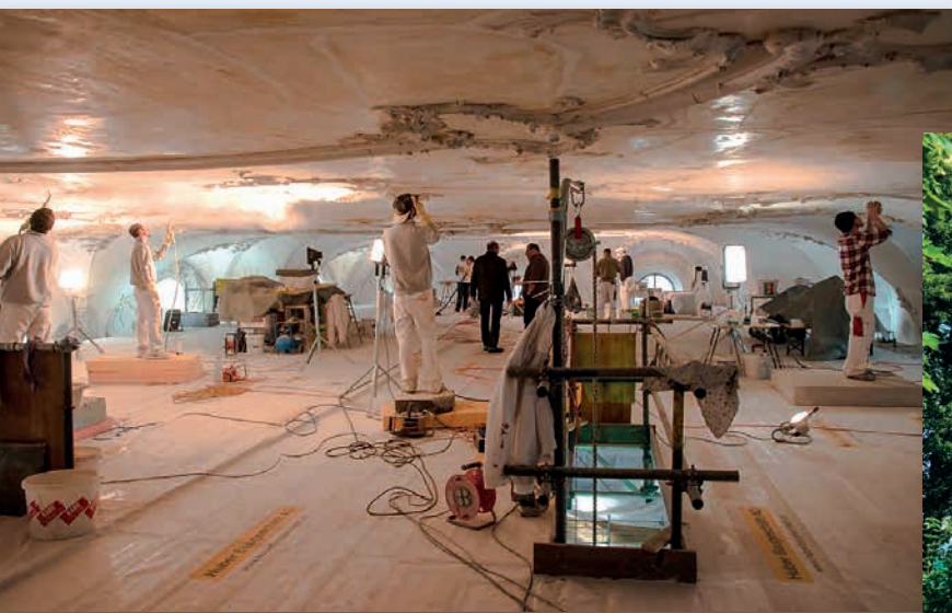
Bauarbeiten in der Kirche
