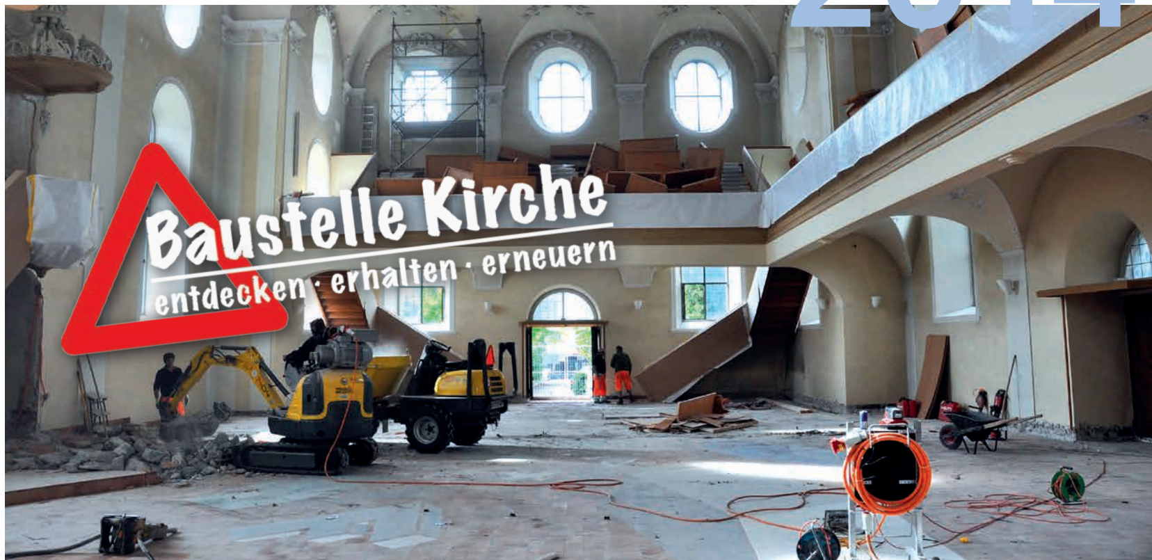
Der alte Fussboden in der Kirche wird entfernt
